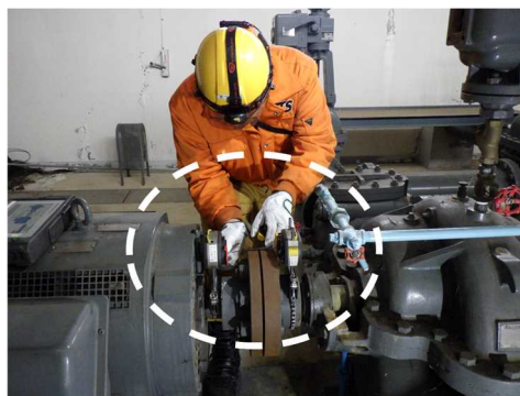
写真-1 レーザーアライメント計測状況
